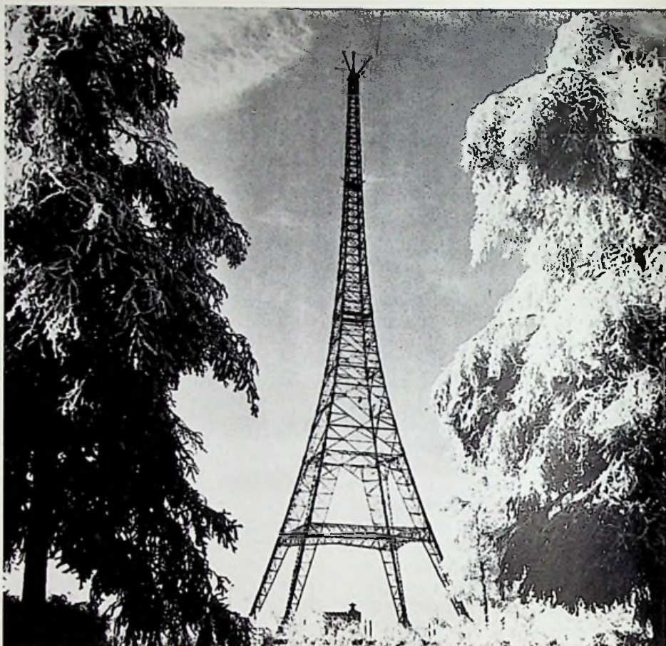
Bild 1 Der 156 m hohe Holzturm des Senders Ismaning soll jetzt verschwinden.
